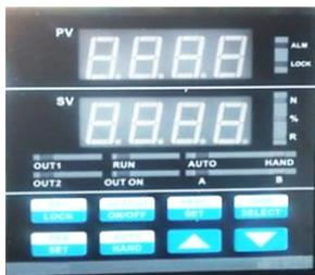
El control de tensión FXACT188 hace parte un sistema de control en lazo cerrado retroalimentado por una sensor de tensión (load cell) que muestra el valor real de la tensión de la película en un display y permite que se haga lo corrección del sistema a través de un control PID. Con una salida hacia freno electromagnético de 0-24VDC o 0-10 voltios hacia un driver..
